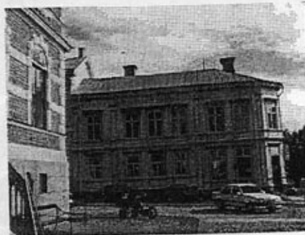
RÅDHUSKONDIORIET Fastigheten Elefanten 1, byggt 1877 av E A Jacobsson som bostad åt handlaren Södergren. På 1930-talet byggdes bottenvåningen om till konditori med ett bageri i källarvåningen.
