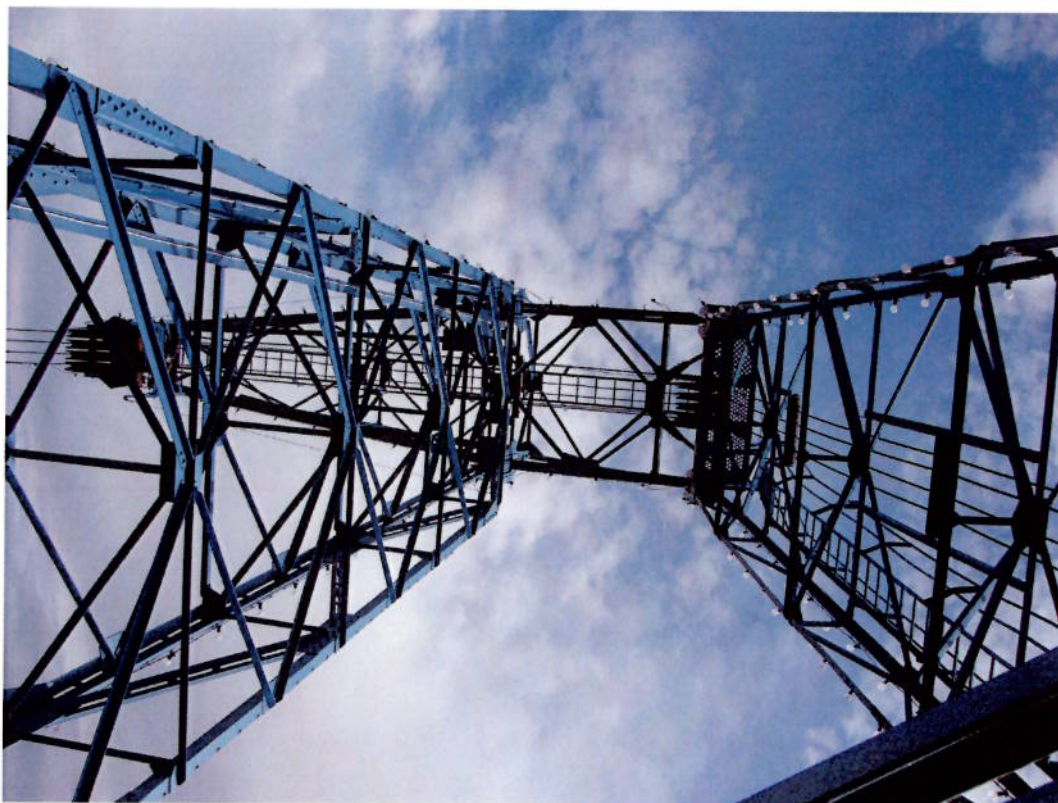
Kranarmens tre delar, stödarm t.v. dragarmen t.h. och över de båda syns jibben. Kranens fackverkskonstruktion är utförd i nitad stålplåt.
