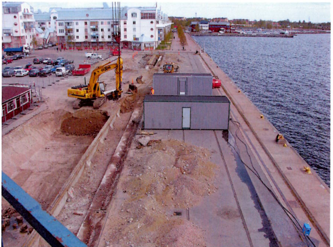
Kajen sedd från kranen mot det nya bostadsområde som nu upptar hälften av den gamla hamnplanen. Till höger skimtar Ettans småbåtshamn.
