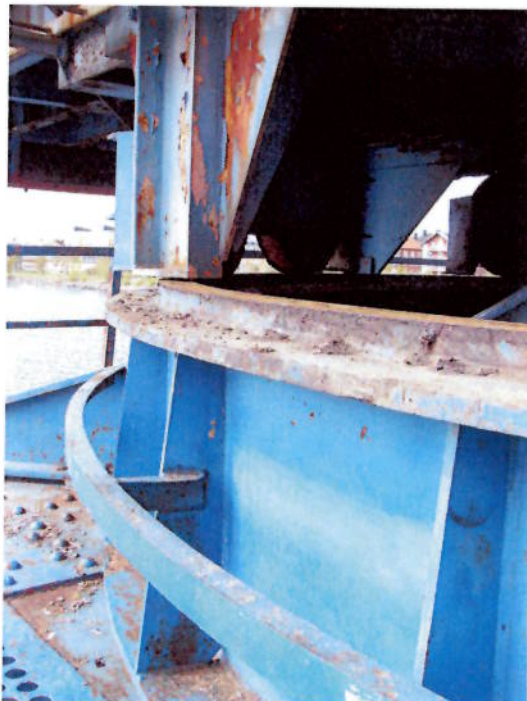
Nedan kranens svängmekanism från ut- resp insidan av svängplattan. Kranen löper på fyra boggiehjul.
