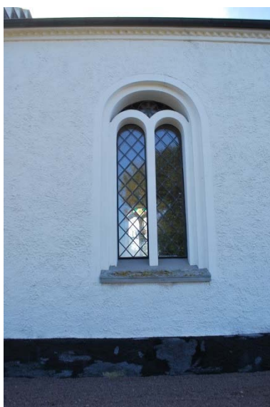
Fönster och takgesims med sågskift.
