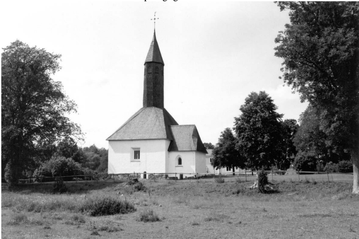
Kyrkans östra fasad och den utbyggda sakristian. Bortom kyrkan skymtar Aspnäs gårds f d huvudbyggnad. Foto Rolf Hammarskiöld 2002. VLM neg B 103 909: 33
