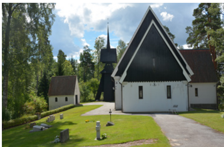
Byggnaden från norr. Vlm_modkaAF-338.
