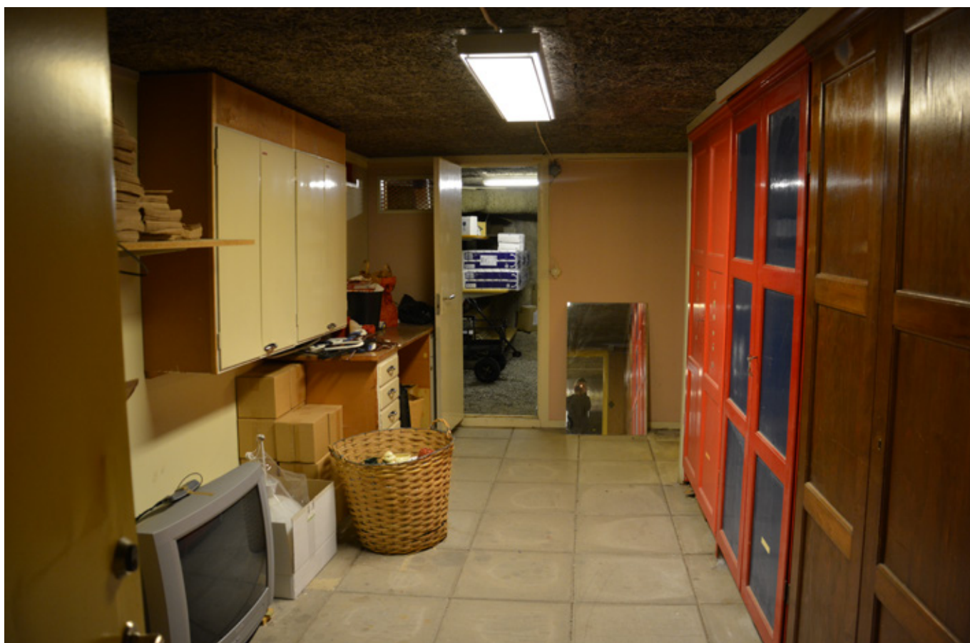
Förråd 013 med betongplattor som golvläggning och träullsplattor i tak. Vlm-modkaEK-3913.
