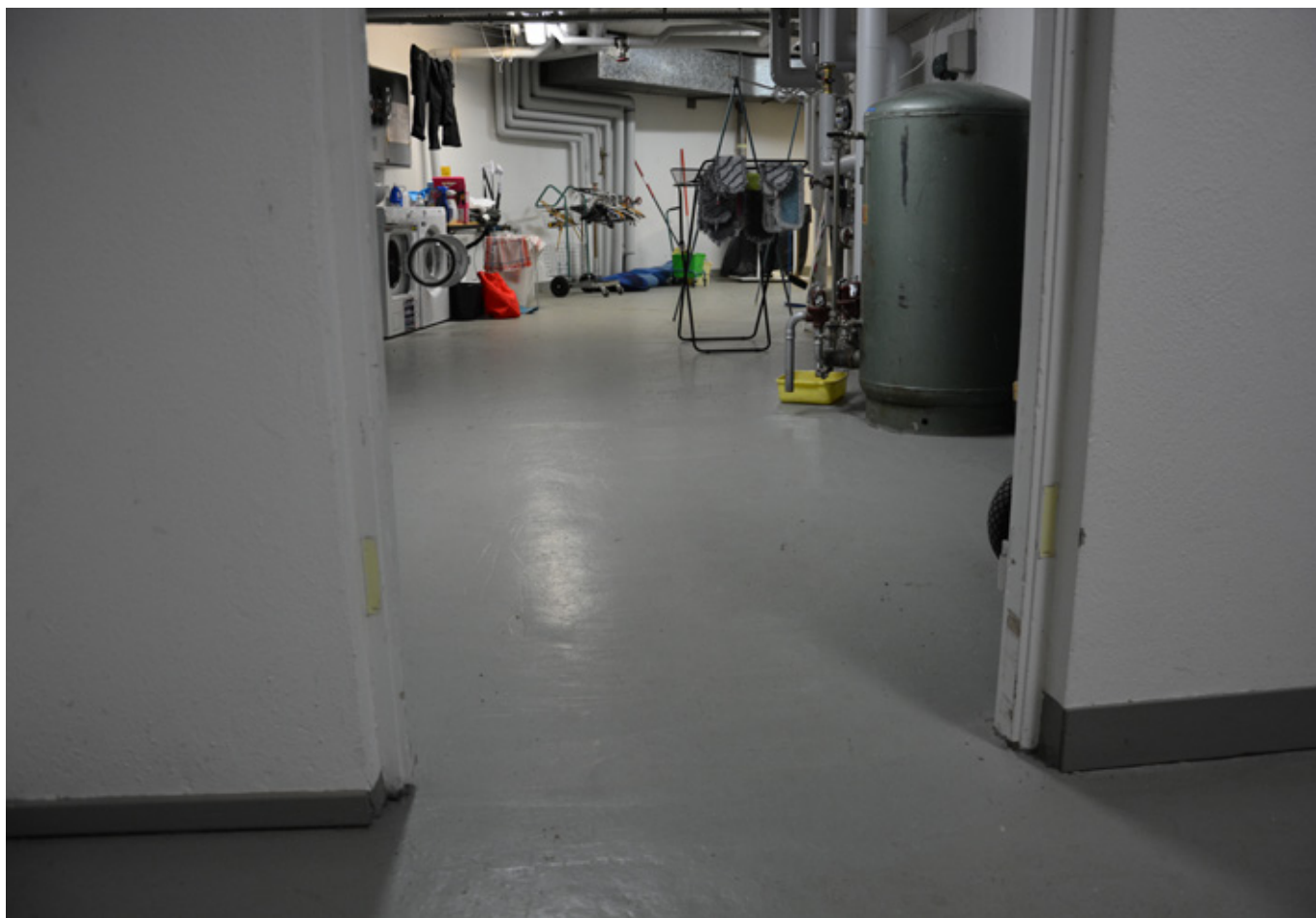
Källarutrymme med gråmålat betonggolv, vitmålade väggar samt gråmålade trälistor. Vlm-modkaEK-3882.
