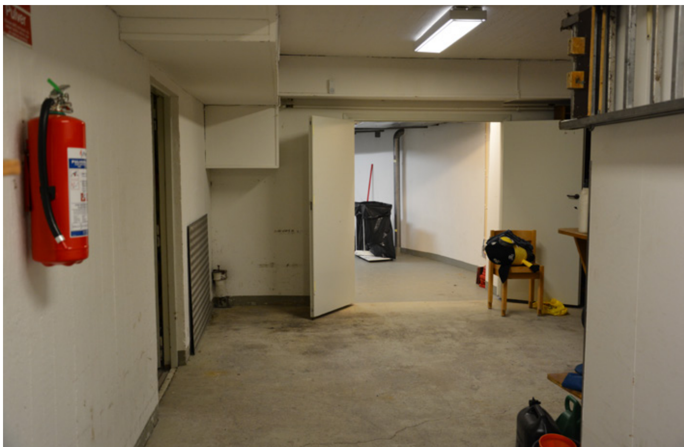
Källarutrymme med gråmålat betonggolv, lysrörsarmatur i rektangulärt plastskydd samt pardörr i trä. Vlm-modkaEK-3894.
