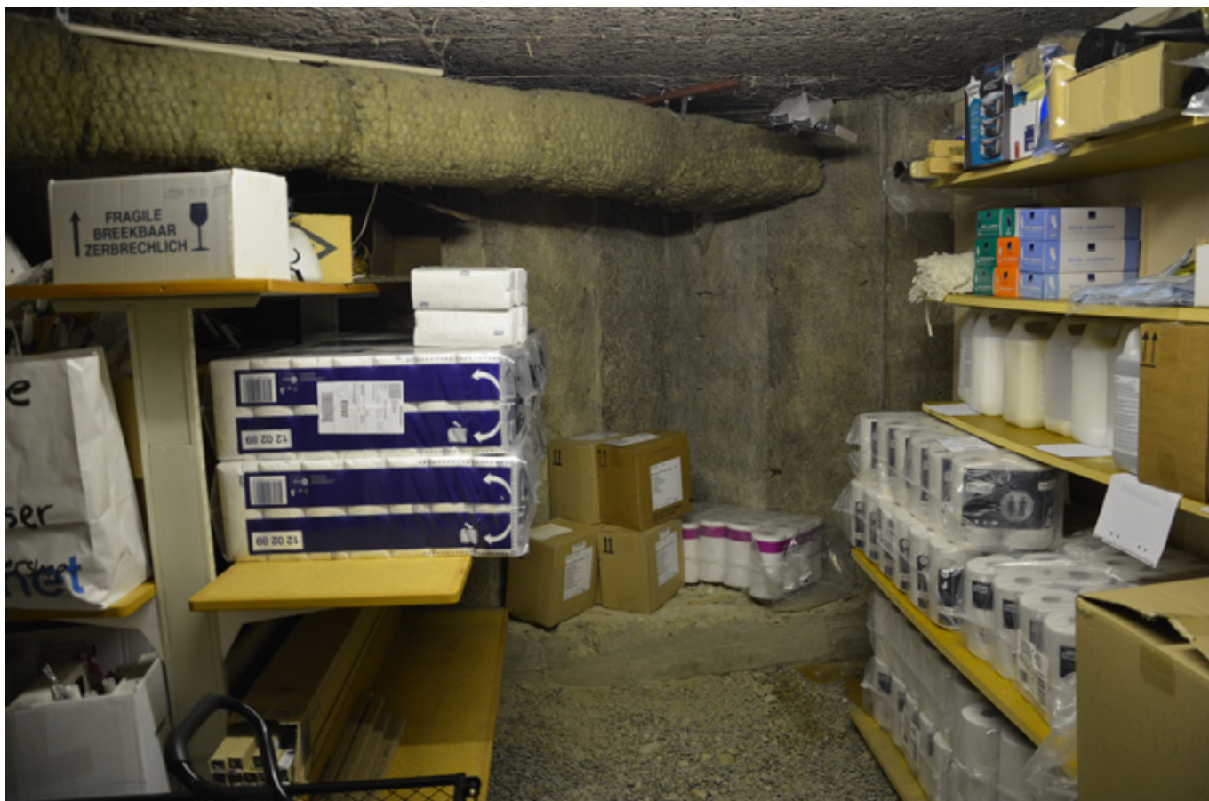
Förråd i källarutrymmet. Vlm-modkaEK-3919.
