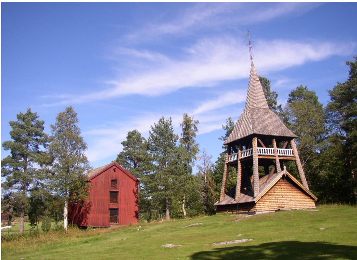
Idenors tjondemagasin samt klockstapel som båda ligger norr om landsvägen genom kyrkoanläggningen. Foto: Daniel Olsson, Läns museet Gävleborg, 2005-08-31.
