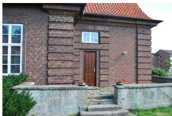
Kor och sakristia, fasad mot väster.
