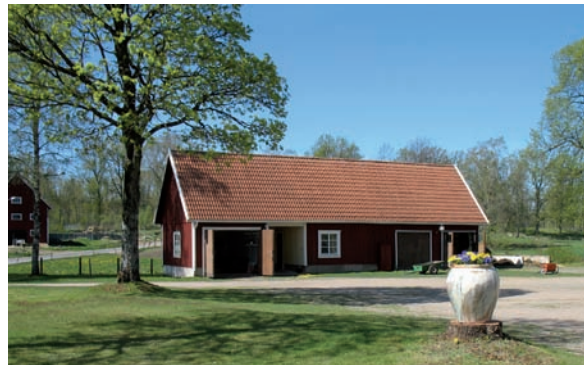
Ekonomibygnad inrymmandes bl.a. garage.
