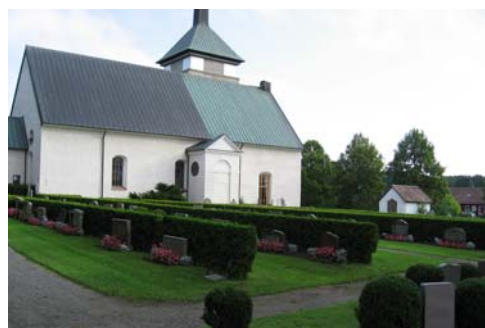
Södra sidan, kvarter B-C.
