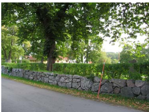
Den västra muren.
