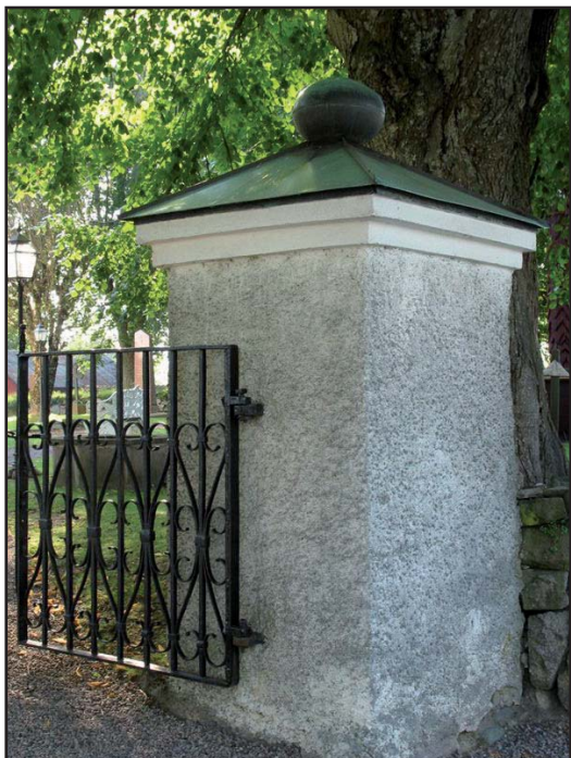
Huvudingång till gamla kyrkogården med grindar och putsade stolpar från tidigt 1800-tal.
