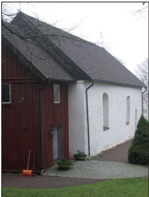
Södra långsidan med den handkappanpassade vapenhusporten.
