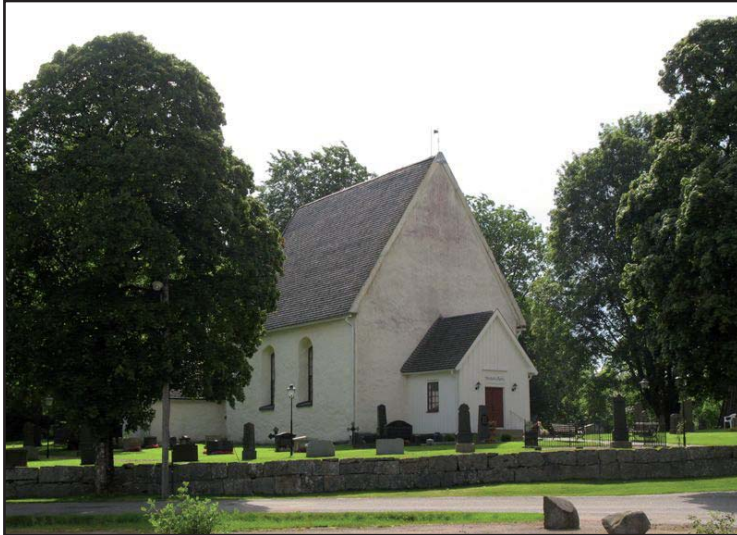
Muren i väster anlades 1894.
