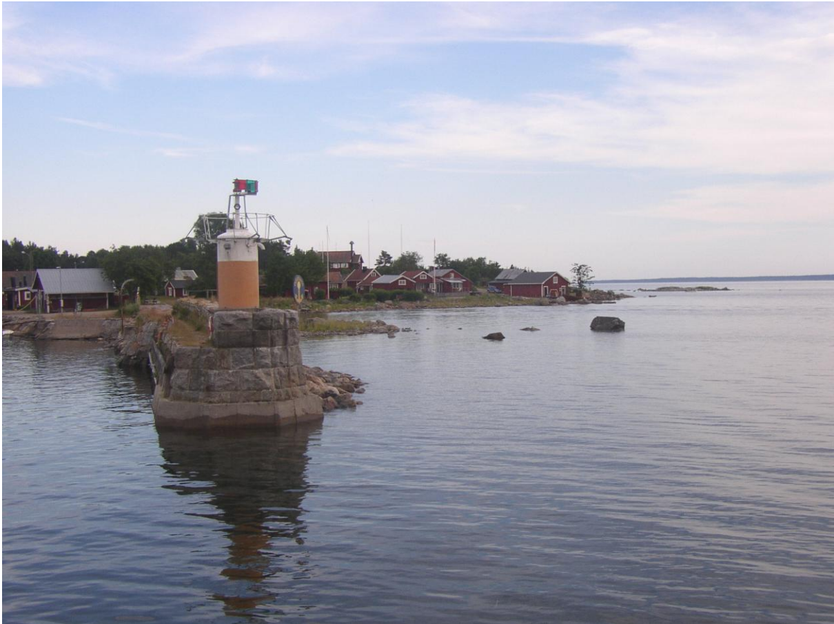
Hölicks fiskeläge ligger på Hornslandets sydspets. Kapellet som ligger på en höjd syns tydligt i bildens mitt, ovanför den traditionella fiskarbebyggelsen. Foto från hamnpiren i väster, 2005-07-08.
