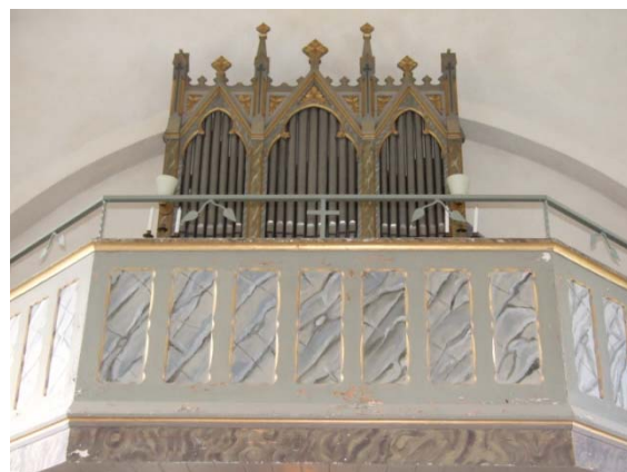
[3]: Orgelläktare och orgelfasad, detaljbild
