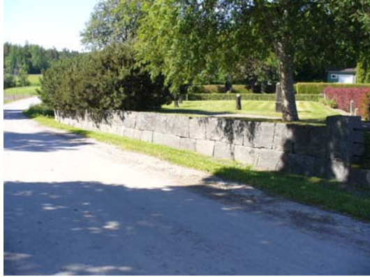
Nordöstra muren från norr.
