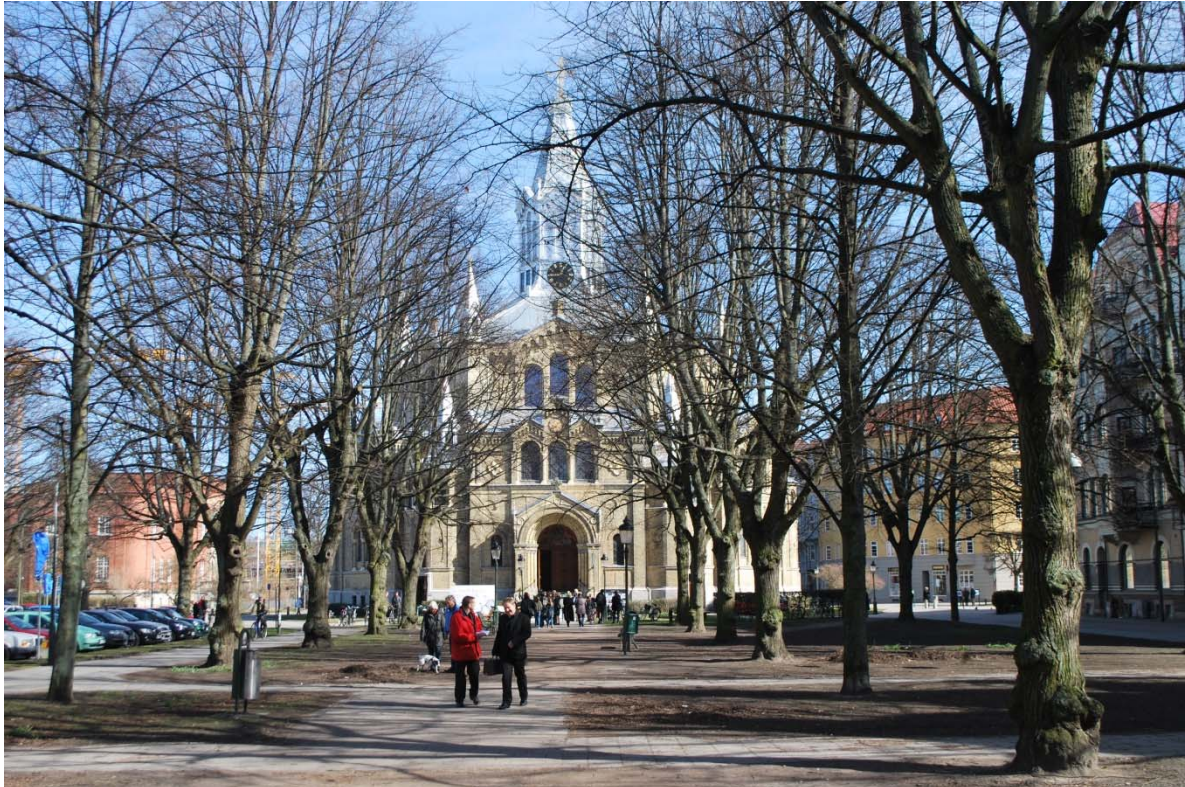
Fasad mot väster från Kungsgatan.
