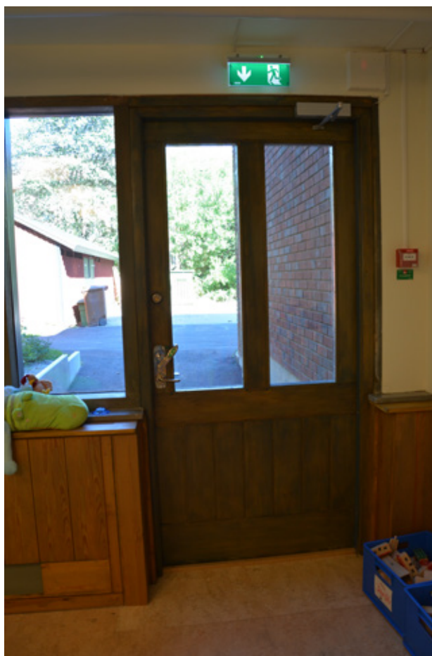
Nyttilverkad dörr i stil anpassad efter befintliga. Vlm_modkaEK-1036.
