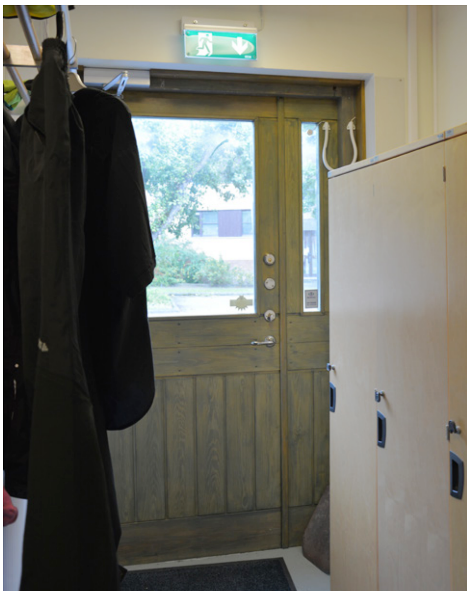
Nyttilverkad dörr anpassad efter befintliga. Vlm_modkaEK-1117.
