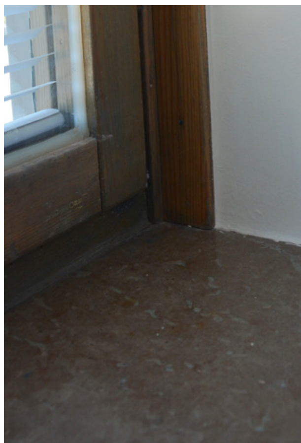
Fönsterbänk av slipad kalksten. Vlm_modkaEK-948
