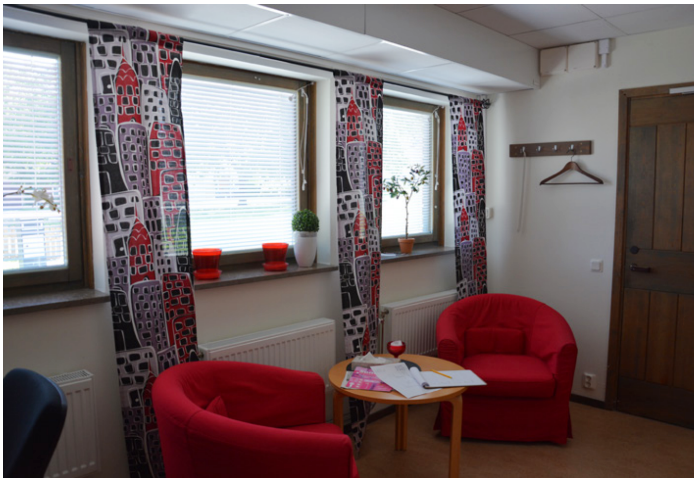
Samtalsrum. Fönster av tryckimpregnerat virke. Vlm_modkaEK-939.
