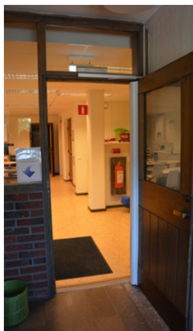
Skiljeväggen till rum 006. Vlm_modkaEK-927.
