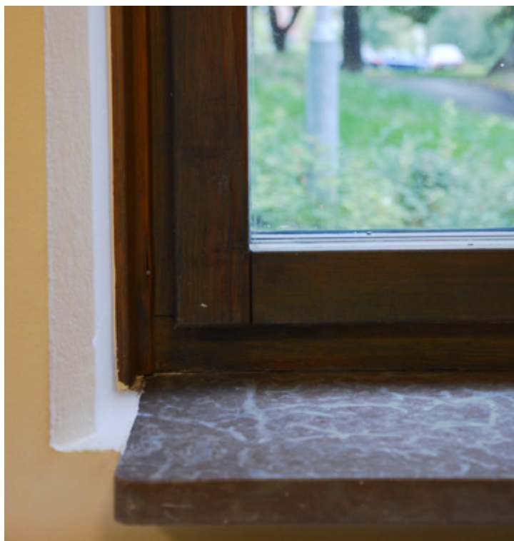
Fönsterbänk i kalksten. Vlm_modkaEK-1102.
