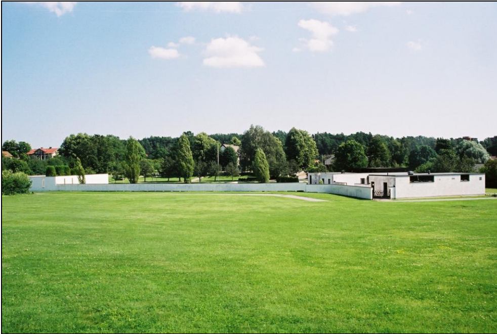
Columbariet och kapellbyggnad med sammanbindande mur från väst. Foto: Lisa Sundström, augusti 2004.
