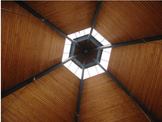
Toppfönstret i kyrksalens tak. De blåaserade limträbalkarna bildar ett dekorativt stjärnmönster.
