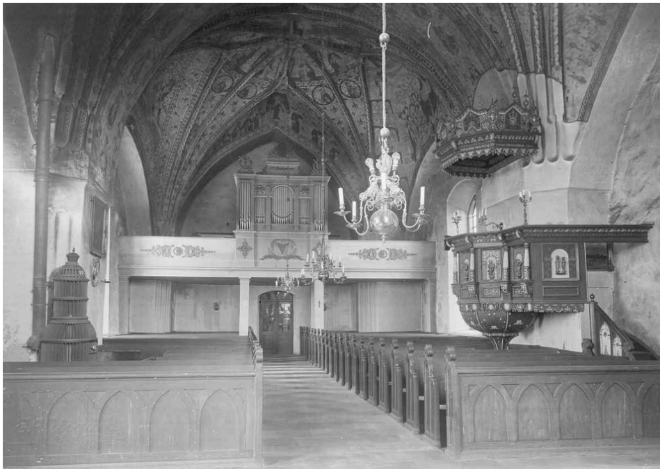
Kyrkorummet i början av 1900-talet hade en öppen, ekådrad bänkinredning, byggd omkring 1870. Uppvärmning skedde med en värmeugn, placerad på södra sidan. Vid fotograferingstillfället var väggarna vitmenade. Deras medeltida måleri frilades 1932.
