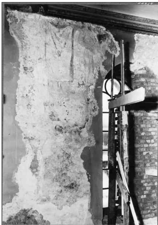
Kalkmålning västra sidoskeppet. Foto B J Jörgensen 1953. Notera fönsterformen.
