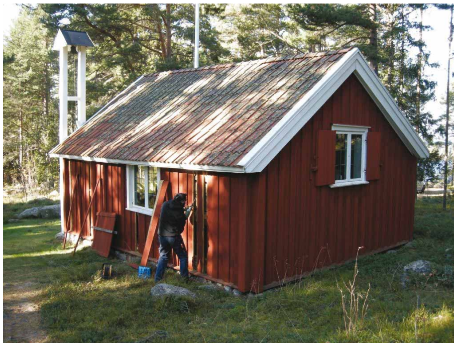
Figur 33. Daniel Åkerman borrar i Bergö kapells timmerstomme. Foto från sydost, Daniel Olsson, Länsmuseet Gävleborg 2011-10-13.
