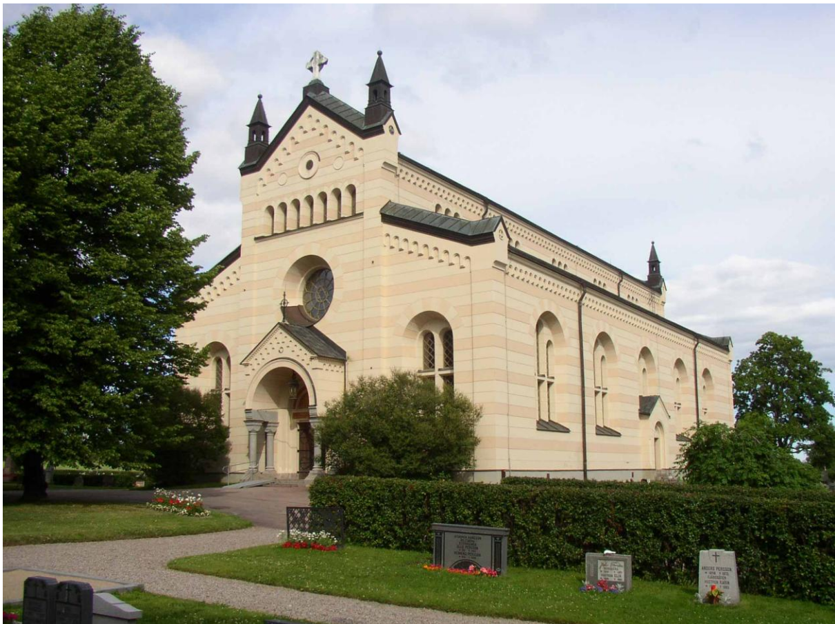
Delsbo kyrka från sydväst. Foto: Daniel Olsson, Länsmuseet Gävleborg, 2004-07-13.
