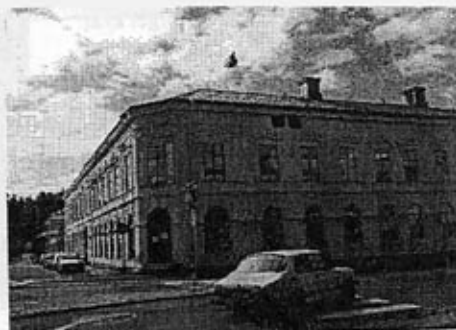
STADSHOTELLET Fastigheten Oxen 7, byggt 1879 av C Dahlgren.
