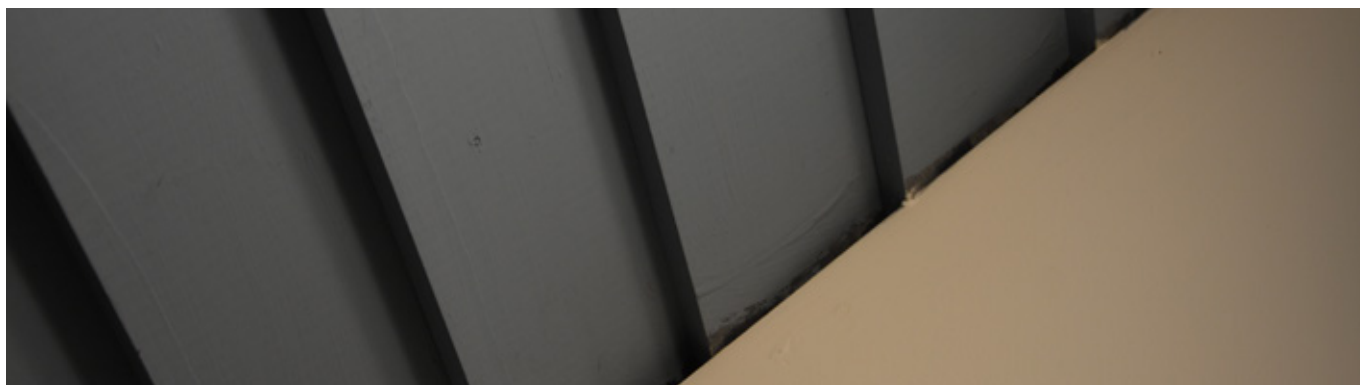
Taket är målat i en gråblå kulör. Den ursprungliga, något mörkare kulören syns i hörnen. Vlm_modkaSB-187.
