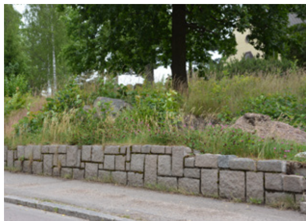
Mur i tuktad natursten i olika storlekar som bildar asymmetriskt förband. Vlm_modkaSB-236.
