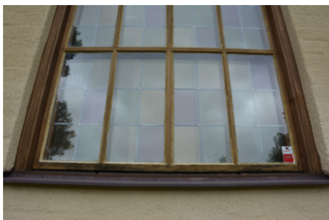
Fönsterbågar av trä med färgat glas i innerbågen. Vlm_modkaSB-218.
