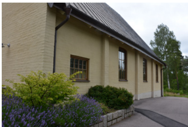
Kyrkans södra fasad med teglet synligt bakom den tunna slämningen. Vlm_modkaSB-214.
