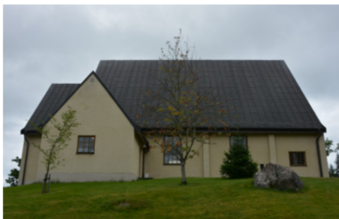
Kyrkans norra fasad med den tillbyggda sakristian. Vlm_modkaSB-227.
