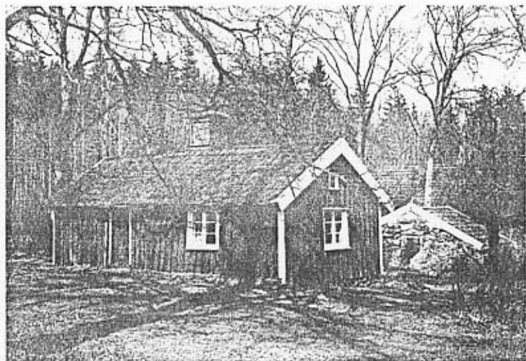
Jordkällaren är valvslagen och utförd i kalkbruksfogad natursten och sadeltaket är klätt med tvåkupigt lertegel.
