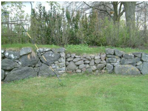
Igensatt öppning i nordmuren.
