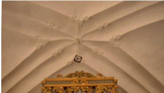
Detaljfoto av de för byggmästarsläkten Romberg typiska ribbvalven med utskjutande koppstenar. Foto: Daniel Olsson, Läns museet Gävleborg, 2004-03-26.
