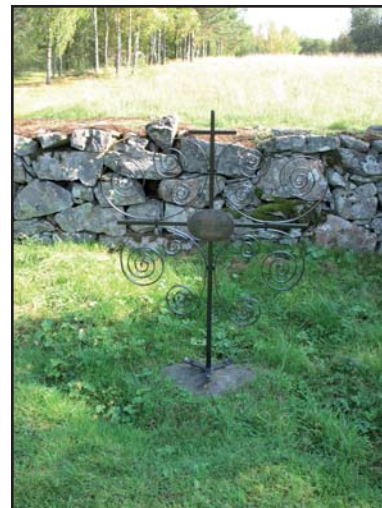
Kyrkogårdsmuren från 1836 är kallmurad av naturstenar. Den är idag till stor del mossbeväxt. Korset är ett smideskors från 1993.
