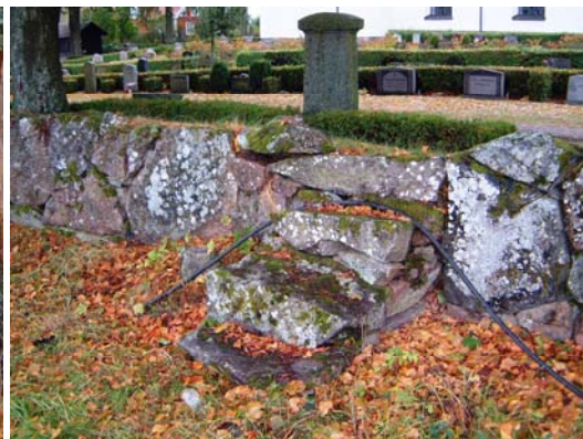
Trappa i norra muren.
