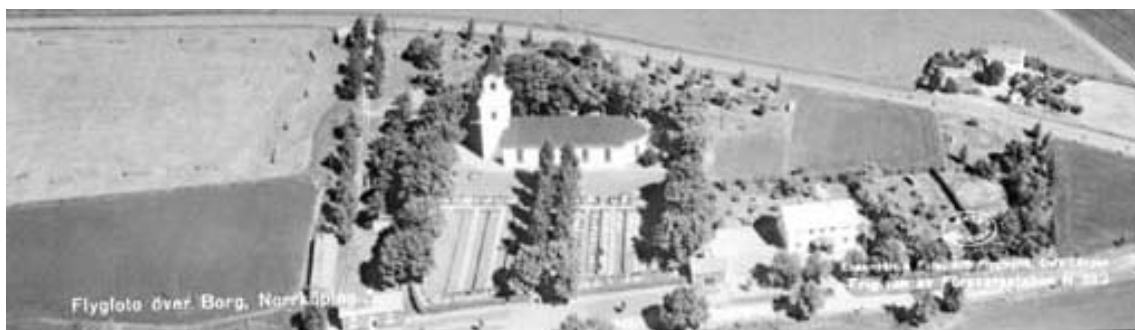
Vykort från 1952. I kv. 1, till vänster om träden i mittgången, framgår det att det tidigare funnits grusgångar inom kvarteret. Dessa finns inte längre kvar. Vid den södra grinden fanns höga träd, utöver de längs mittgången. De tio lindarna längs mittgången finns ännu kvar, dock ej de vid grinden. I det sydöstra hörnet fanns fortfarande den lilla byggnaden kvar som föregående foto visar. Denna finns inte numera kvar. Foto ur Östergötlands läns museums samlingar.
