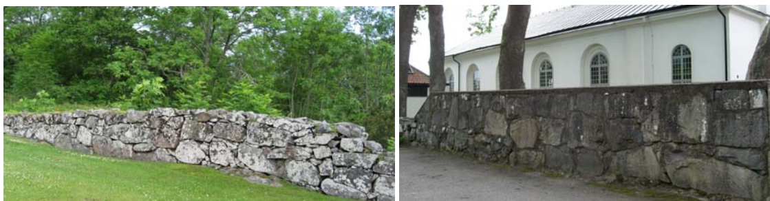
Vänstra bilden visar den norra muren längst mot öster medan den högra bilden visar den del av muren som sträcker sig längs parkeringen bort mot väster.
