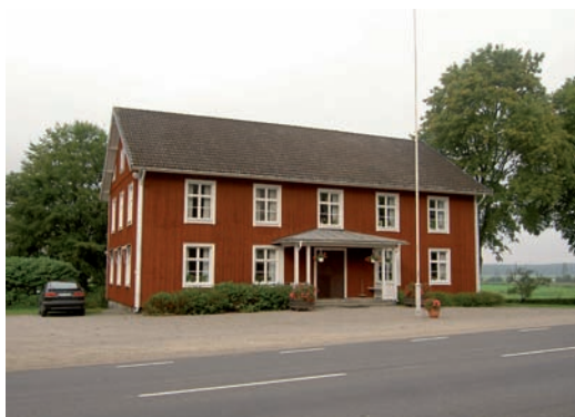
Byskolan som idag används som församlingshem. Strax vänster om byggnaden finns en ekonomibyggnad som används som redskapsbod för skötseln av kyrkogården.
