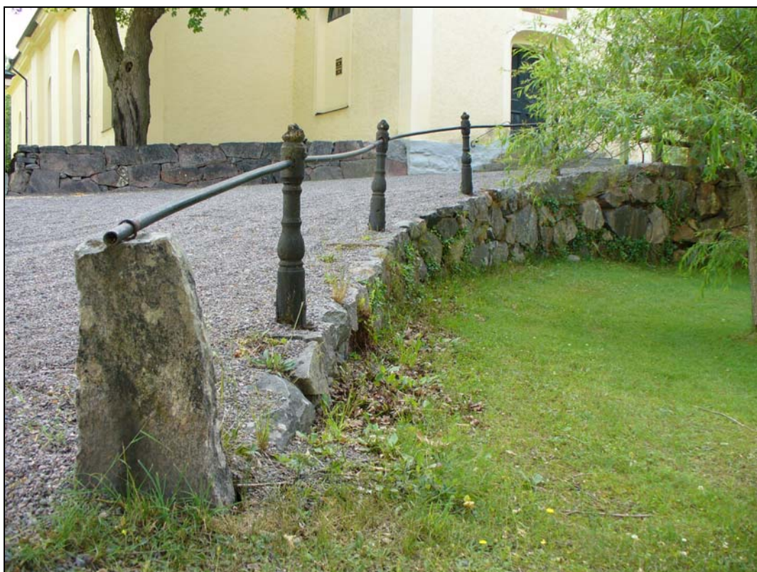
Staket med svarvade stolpar i trä vid det arrangerade området väster om kyrkan.
