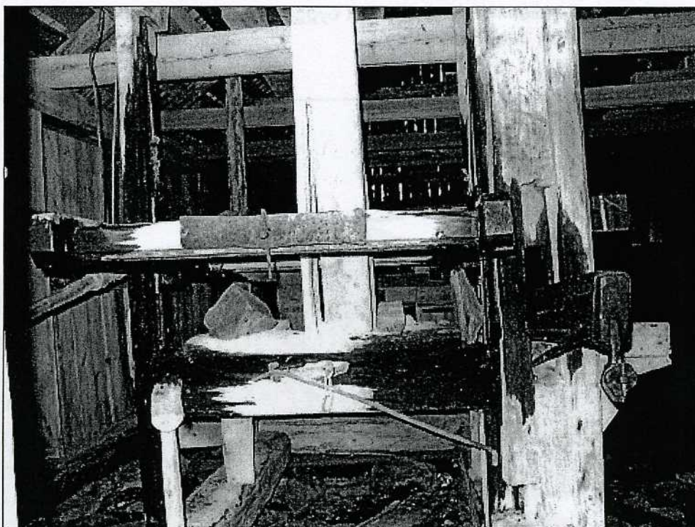
Sågmaskineriet före upprustning. Foto: Mimmi Göllas.
