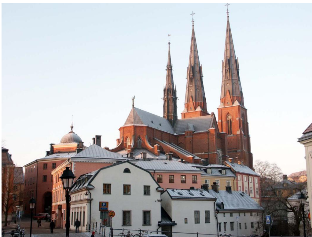
Vy från Gamla torget 2005. Här ses de svankryggiga strävbågarna som är resultatet av 1940-talets skyddsarbeten. Norra delen av koret har kvar de nygotiska strävbågarna från 1890-talet men berövade sina fialer.
