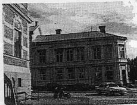
RÅDHUSKONDIORIET Fastigheten Elefanten 1, byggt 1877 av E A Jacobsson som bostad åt handlaren Södergren. På 1930-talet byggdes bottenvåningen om till konditori med ett bageri i källarvåningen.
