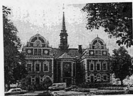
RÅDHUSET Fastigheten Rådhuset 1, byggt 1869 av G N Runer, ombyggt 1877 av E A Jacobsson.
