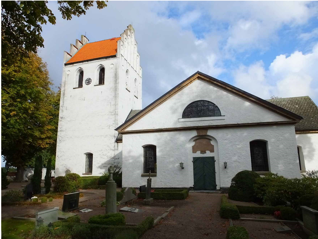
Kyrkan sett från södra sidan.
