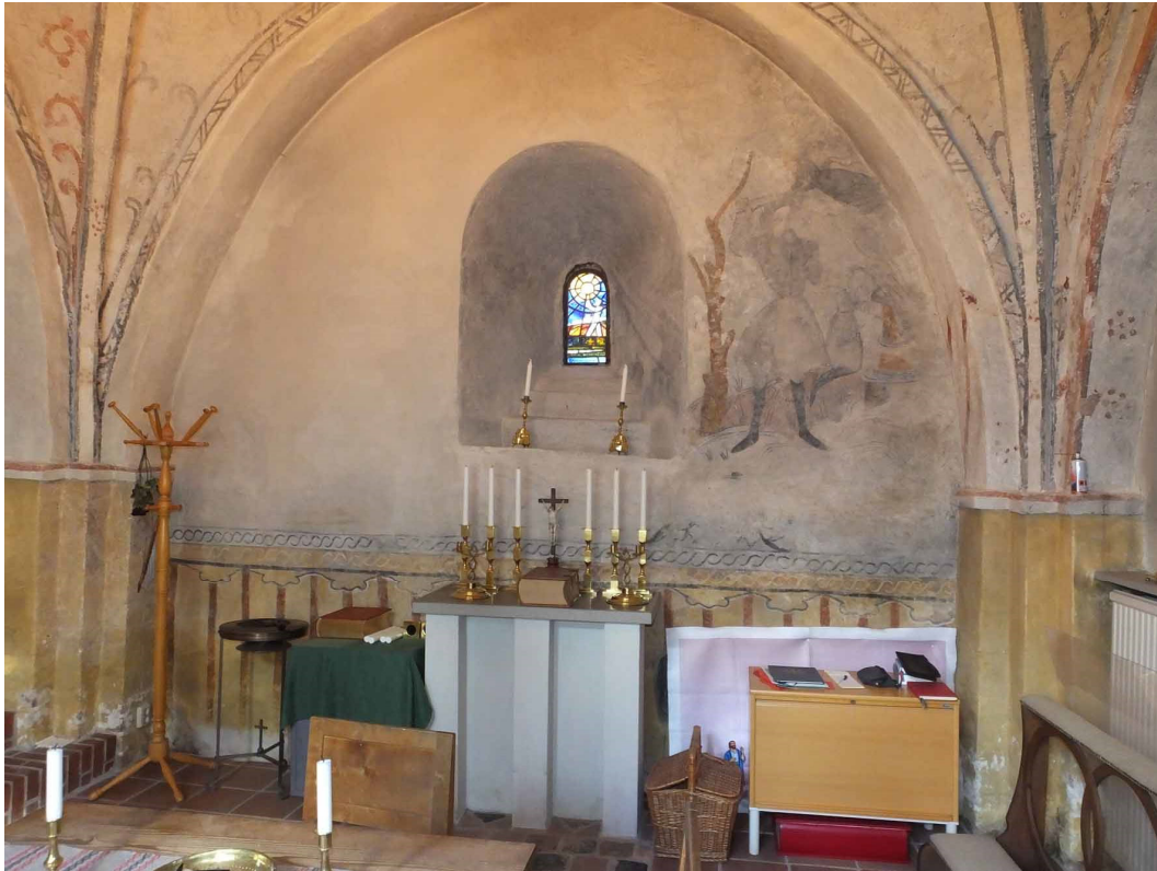
Kyrkans medeltida kor utgör sakristia. Kalkmålningar finns bevarade på väggar och valv och på norra väggen finns en ursprunglig fönsteröppning.
