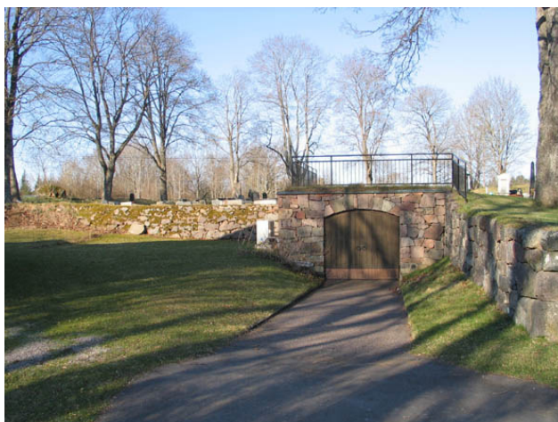
Bisättningskällaren placerad under kyrkogården i en vinkel i stödmuren. (KI Kråksmåla kyrkog 005)
