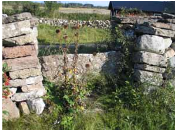
I kyrkogårdens mur norr om kyrkan finns en ingång till kyrkogården. Här finns idag en kantställd kalkstensskiva. (KI Källa gamla kyg 067)
