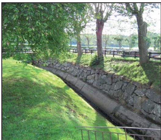
Kyrkogården omgärdas av en kallmur i granit. I söder begränsas kyrkogårdens utsträckning av en bäck.
