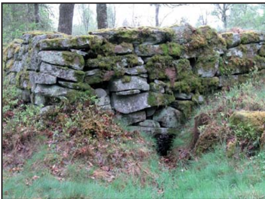
Kallmur med utlopp för dike i nordost.
