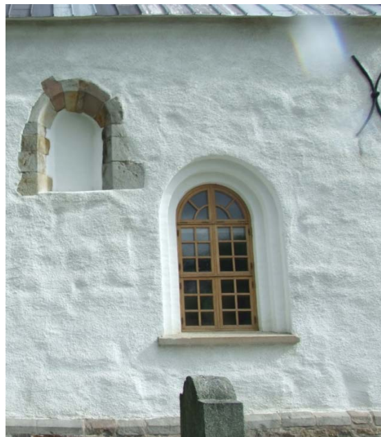
[2]: Frilagd omfattning av ursprungligt fönster
