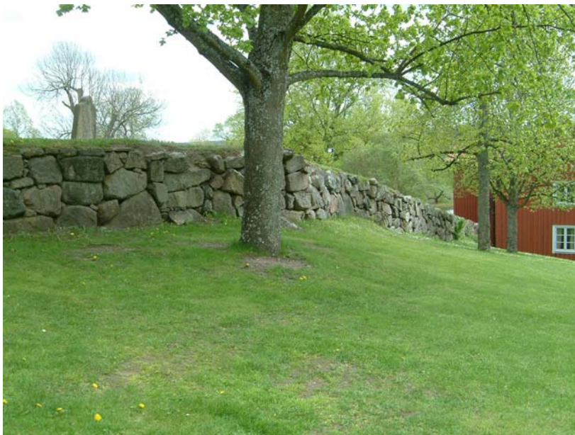
Västmuren. Muren visar en tydlig murskarv på det ställe där marken börjar slutta mot söder (alldeles till höger om trädet). Skarven visar att kyrkogårdsmuren ursprungligen bara omfattat det plana högst belägna området och blivit utbyggd senare.
